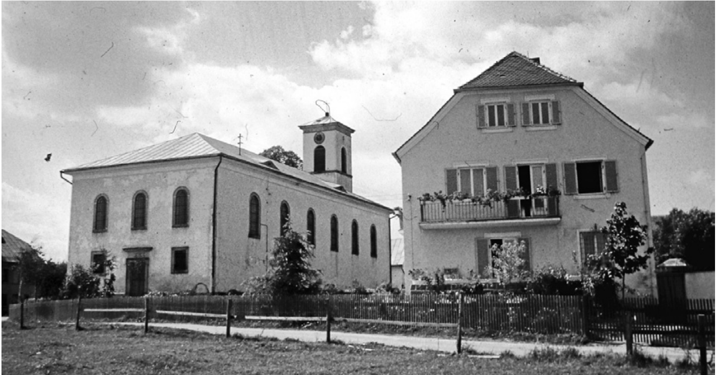
Eine alte Ansicht aus den 1960er Jahren.
